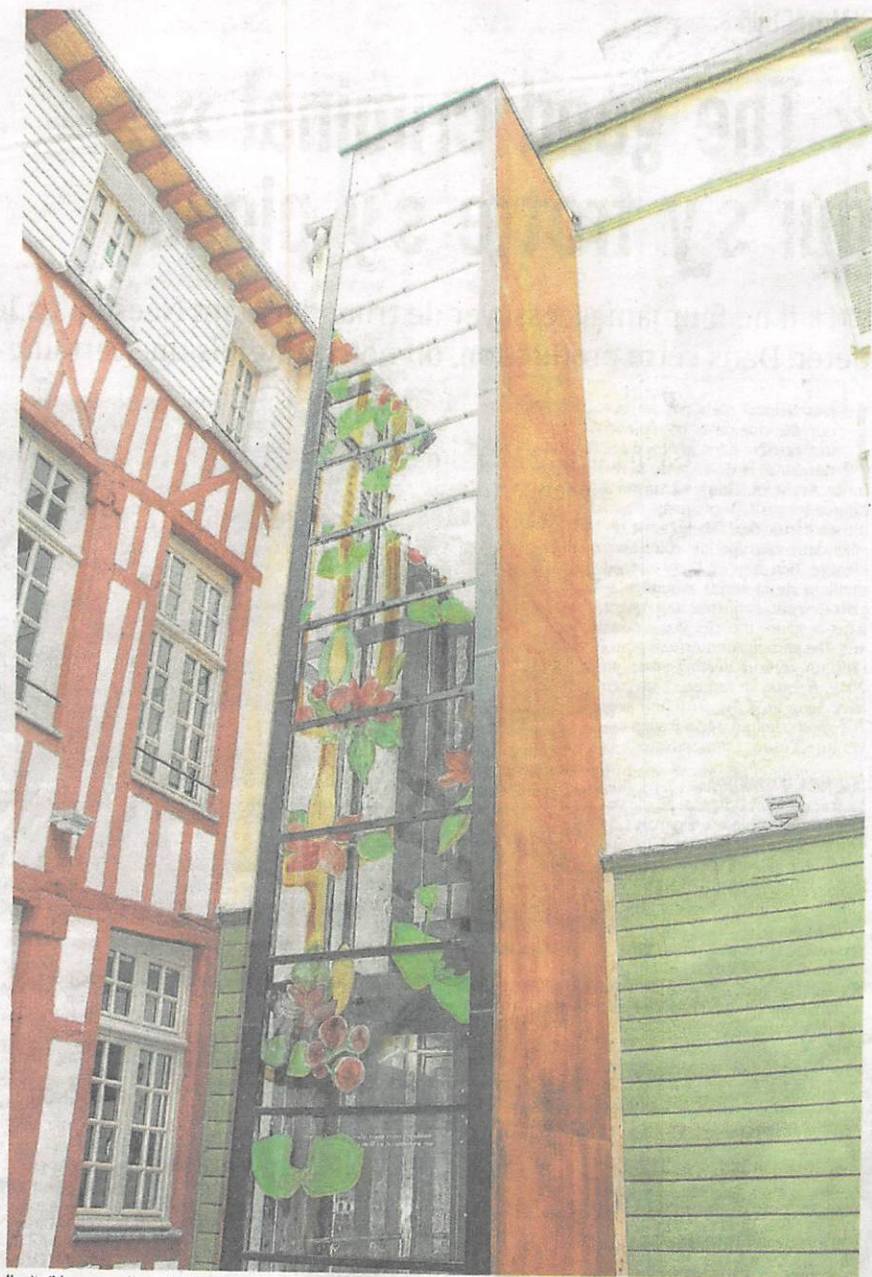
Un vitrail hors-norme. L'évocation d'une ménorah, sur neuf mètres de hauteur, pour habiller dans une transparence fleurie, la cage d'ascenseur.
